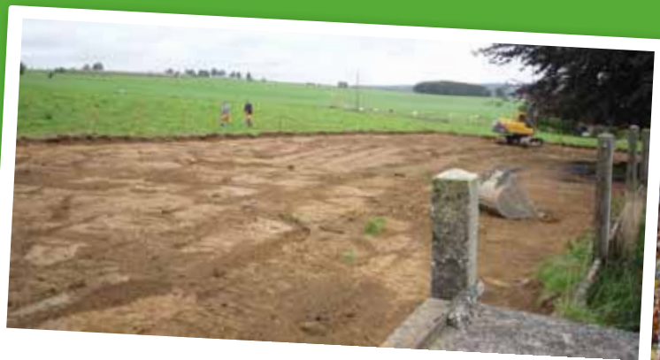
Les travaux de terrassement et d'aménagement pour l'agrandissement du cimetière de Rahier.
