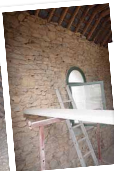
Les travaux à l'ancienne morgue du cimetière de Chevron : restauration de la toiture, des châssis, de l'intérieur et transformation en columbarium.
